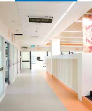
Esempio di posa di linoleum effettuata su livellatura in Ultraplan - Victorian Comprehensive Cancer Centre - Melbourne - Australia
