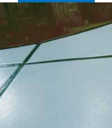
Particolare dell'applicazione di Ultraplan su pavimento in ceramica esistente previa applicazione di Eco Prim T Plus
