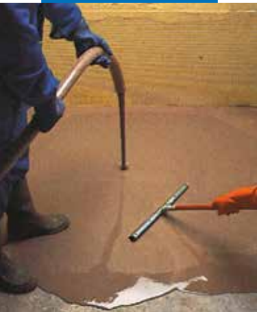
Applicazione di Ultraplan con pompa e successiva raclatura
