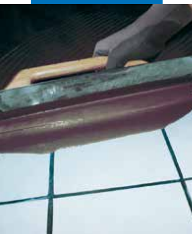
Stesura con spatola metallica di Ultraplan su pavimento esistente in ceramica previa applicazione di Eco Prim T Plus
